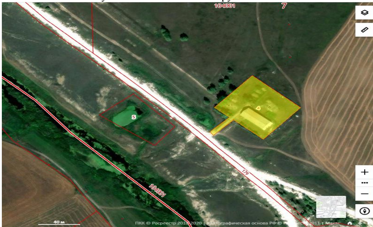
Рисунок 16.1. Очистные сооружения с. Коелга
